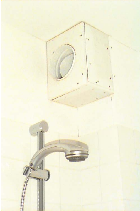
Figuur 3: Regelbare klep in de badkamer
