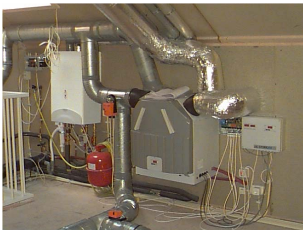
Figuur 4: Warmteterugwinningssysteem
