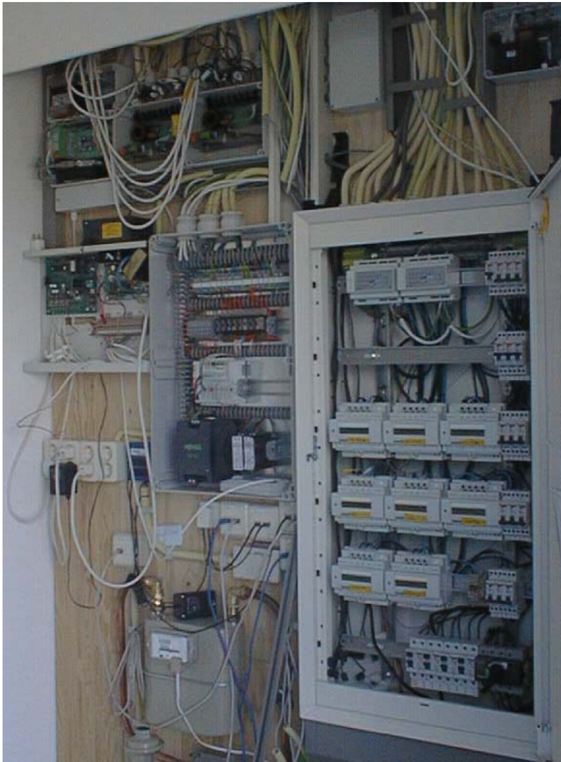
Figuur 10: Meterkast voor domotica-systeem
