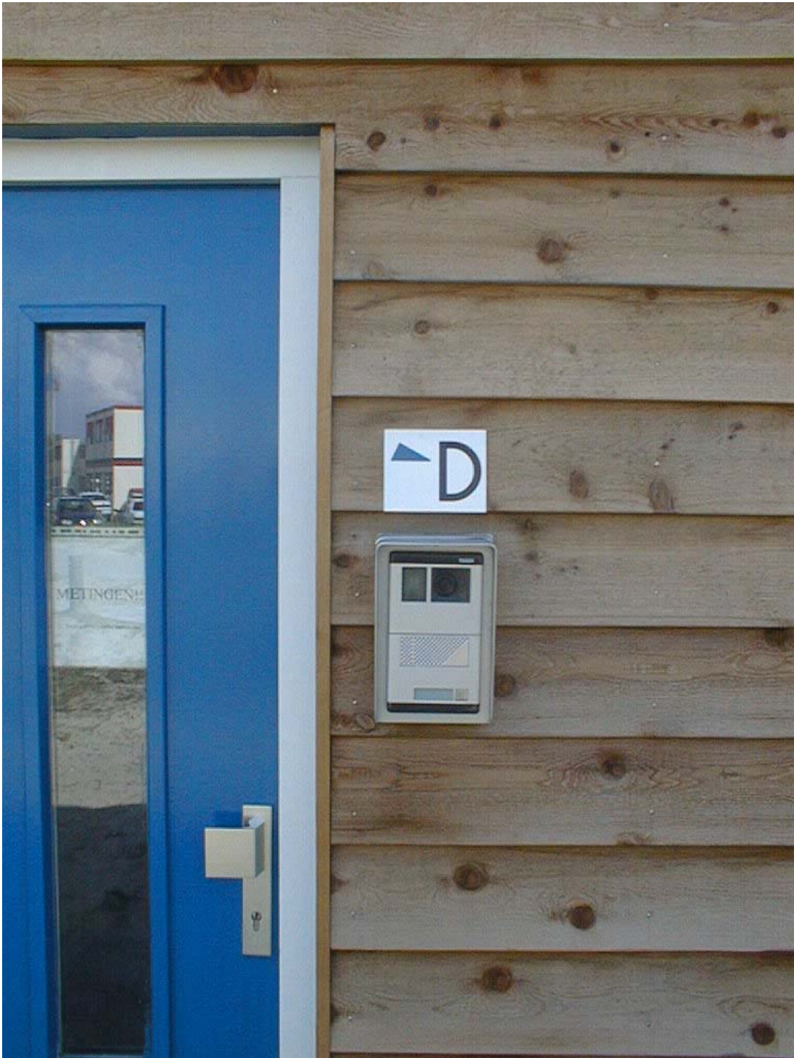
Figuur 8: Videocamera als toegangscontrole
