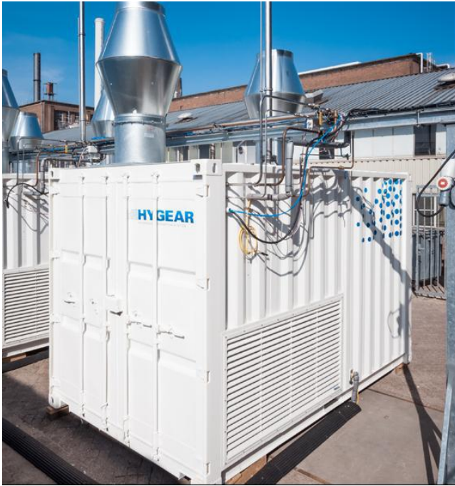
Figuur 5: Prototype membraanmodule van HyGear voor scheiding van waterstof
