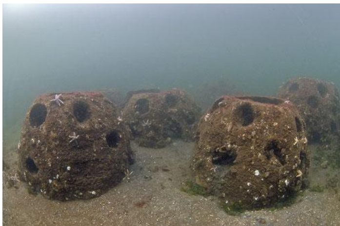
Figuur 4.2 Kunstriffen (Reefballs) gemaakt van voorgevormd beton, nabij Dreischor in Zeeland (© Reefball International) [ www.reefball.org ]
