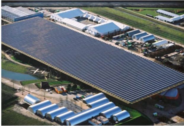
Figuur 2.8 Het grootste PV-dak van Nederland bij de Floriade, goed voor een elektriciteitsproductie van 2,6 miljoen kWh per jaar
