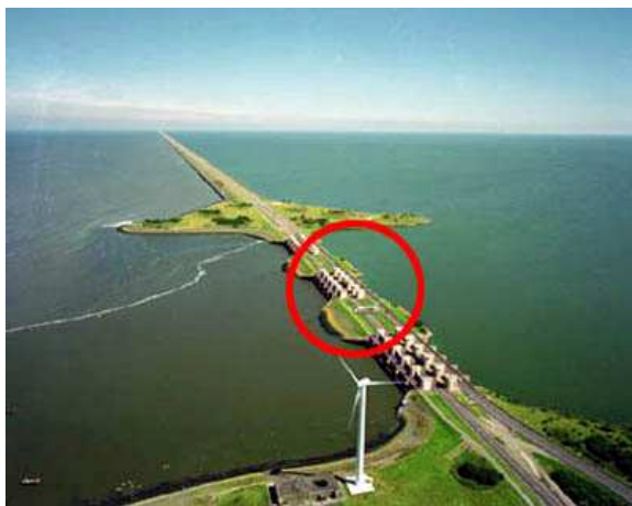
Figuur 3.1 Spuisluizen Den Oever met 50 kW prototype Tocado vrije stromingsturbine
