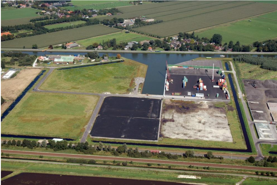
Figuur 4.1 Toepassing LD staalslak en AVI bodemas in Hoogezand-Sappemeer. Rechts naast de insteekhaven is de containerterminal zichtbaar. Hier is de veenlaag afgegraven en staalslak toegepast tot 50 cm boven de GHG. Onder de insteekhaven is de locatie opgehoogd met vormzand/LD-staalslak (0-20)/AVI-bodemas met tijdelijke afdichting
