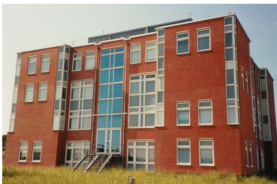
Figuur 2: Zuidgevel gebouw 40
