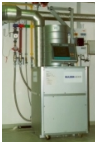
Figure 7-5 Sulzer Hexis \mu -WK (veldtest)systeem.
