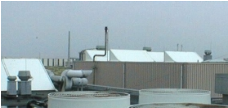
Figuur 2: links: daksheds op fabriekshallen, gezien vanaf de zuidzijde; rechts: de ruimte onder de daksheds behoeft een aanzienlijk geringere inzet van kunstlicht.
